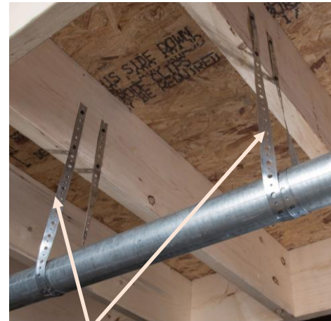
Supports métalliques en traction
